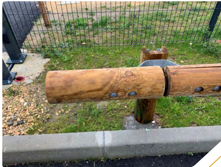
Parking d'un bâtiment public
